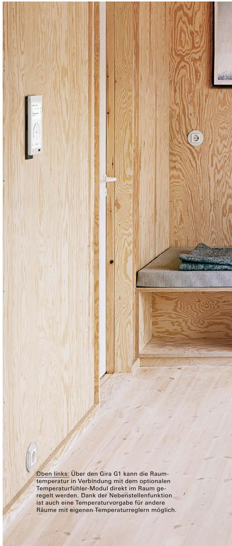
Oben links: Über den Gira G1 kann die Raumtemperatur in Verbindung mit dem optionalen Temperaturfühler-Modul direkt im Raum geregelt werden. Dank der Nebenstellenfunktion ist auch eine Temperaturvorgabe für andere Räume mit eigenen Temperaturreglern möglich.
